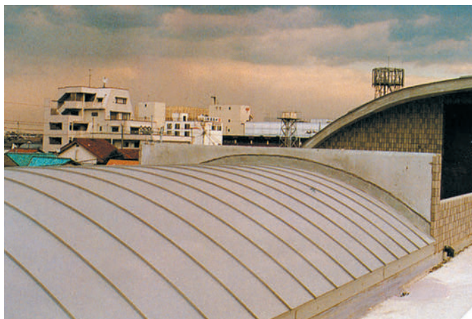
カラーステンレス0.4 マンション4階屋上写真
